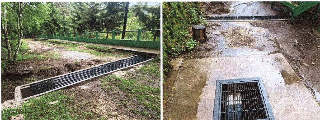
Foto 26-27: Zanja y pozo de absorción para conservación de suelo y manejo de agua pluvial en el mirador principal y granja educativa
